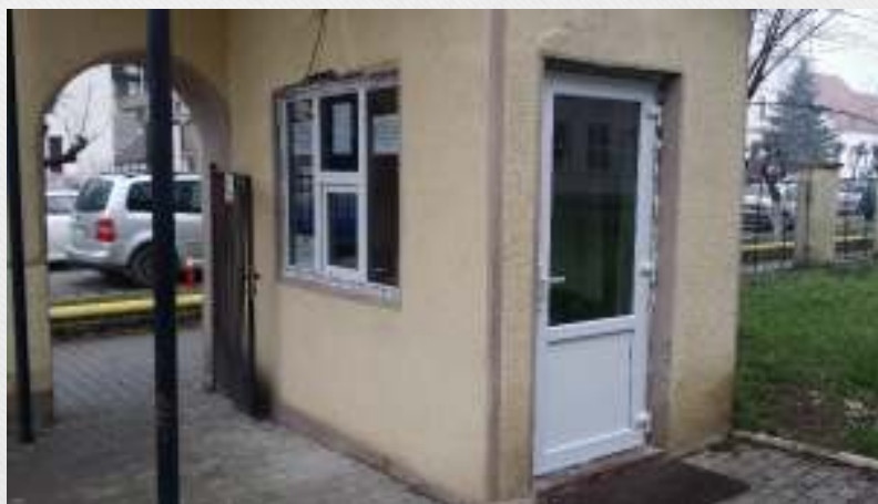
Inlocuire geam și ușă - birou portar
