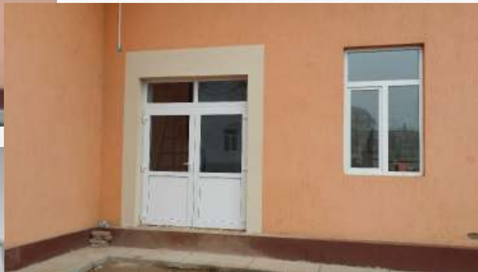
Montare a doua uşă Corp E - ISU
