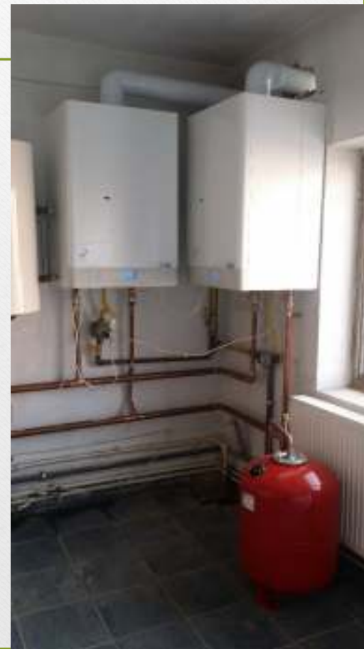
Inlocuire centrala termica corp E
