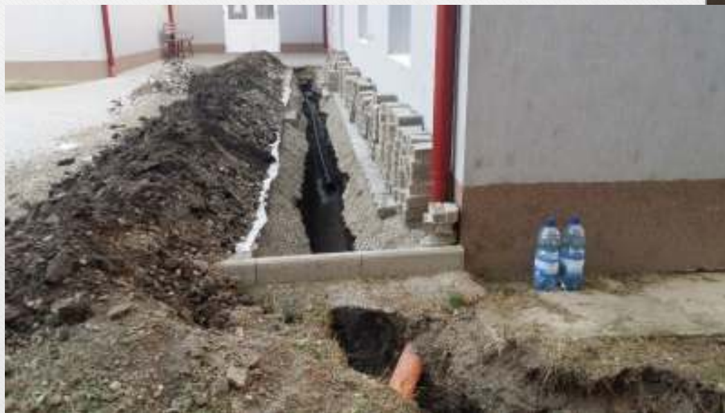
Instalatie canalizare noua la GPN
